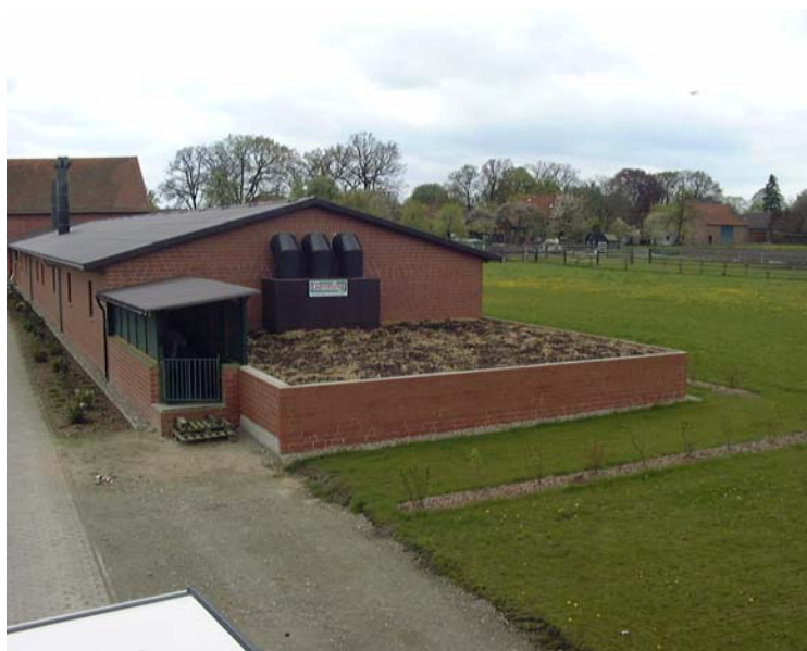
Rysunek 3. Ograniczenie odoru w wentylowanym powietrzu przy wykorzystaniu biofiltra (fot. Lundgard N.)
